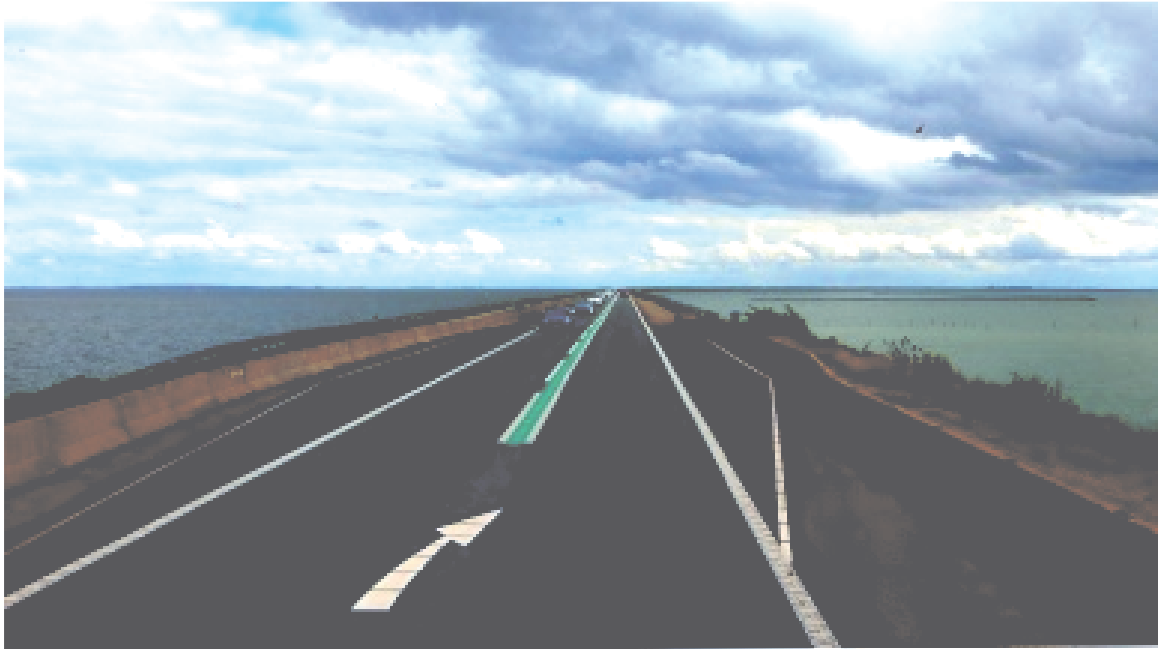
Cesta do Naardenu vedla také po hrázi Houtribdijk, dlouhé 28 km
